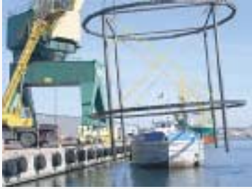
Karlshamnin Ro-Ro laituri s. 4-6
