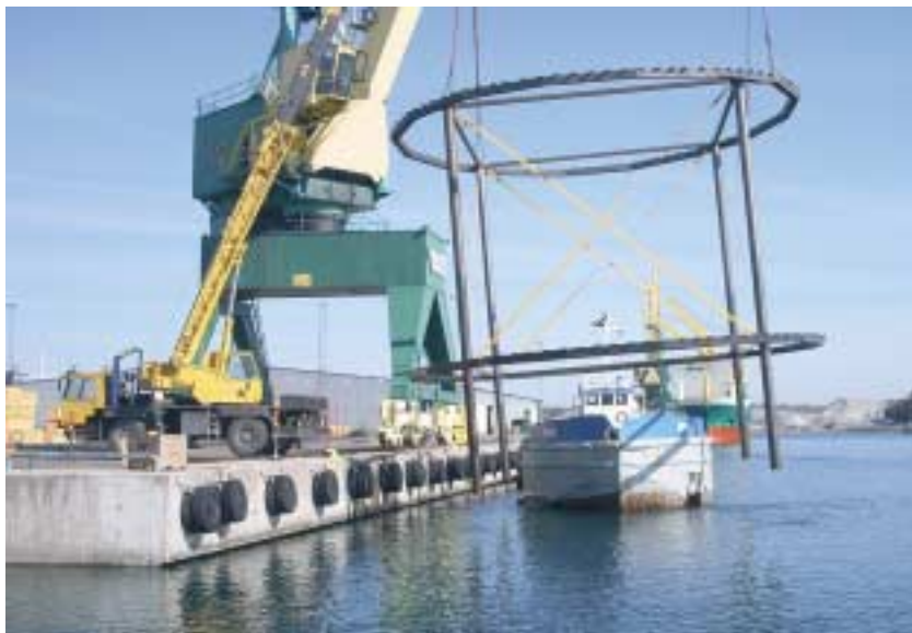
Tihtaalin asennusmalline nostetaan proomulle
