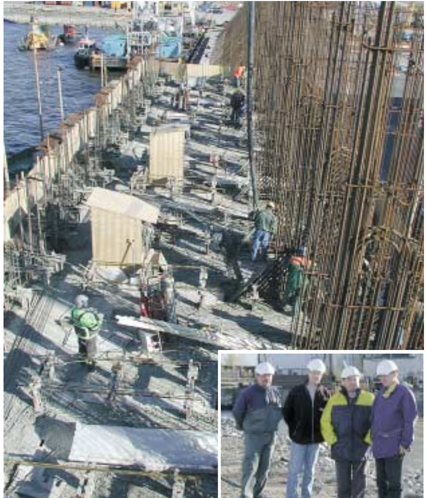
Laiturielementtien liukuvalu käynnissä
